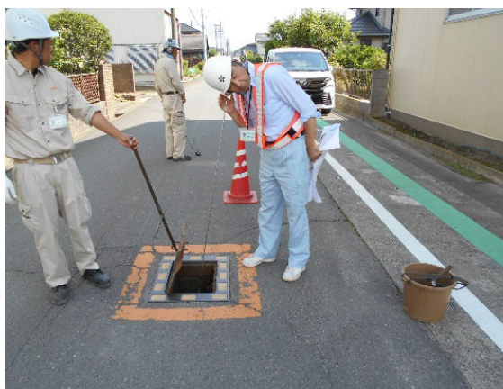
音聴棒を用いた漏水調査
