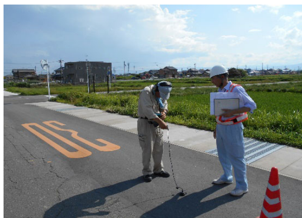
漏水探知機を用いた漏水調査
