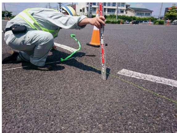
路面陥没の状況
