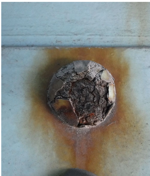
写真-7 高力ボルト頭部の腐食状況
