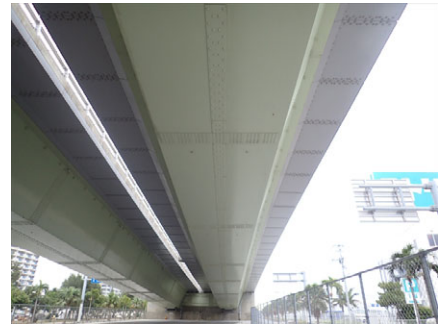
c) 鋼箱桁（ワンボックス）
