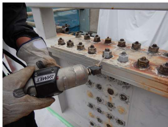
b) コールドスプレー施工状況②
