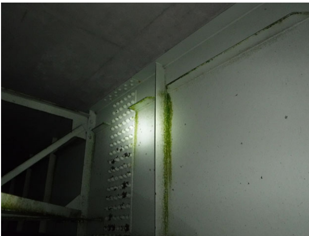
a) 桁面の苔の発生
