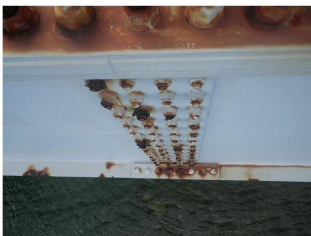
a) 架設後11年経過
