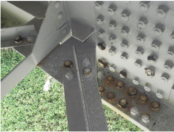
a) 架設後9年経過
