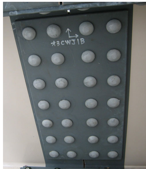
写真-8 連結部のプレコートボルト
