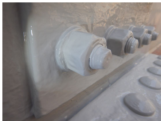
d) 塗装完了後の高力ボルト部
