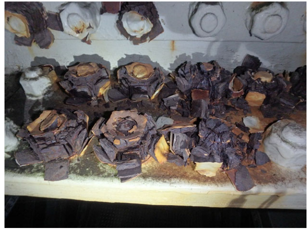
b) 架設後14年経過
