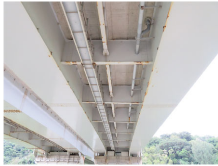
b) 鋼箱桁（ツーボックス）
