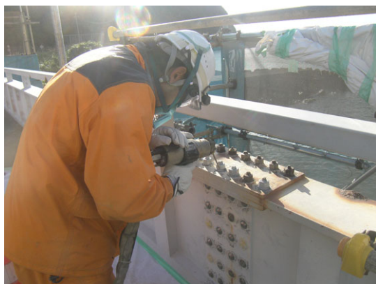
a) コールドスプレー施工状況①
