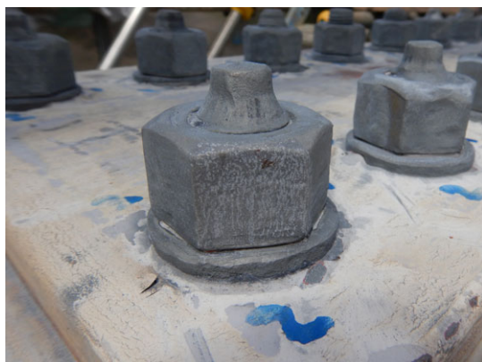
c) 施工直後の高力ボルト部
