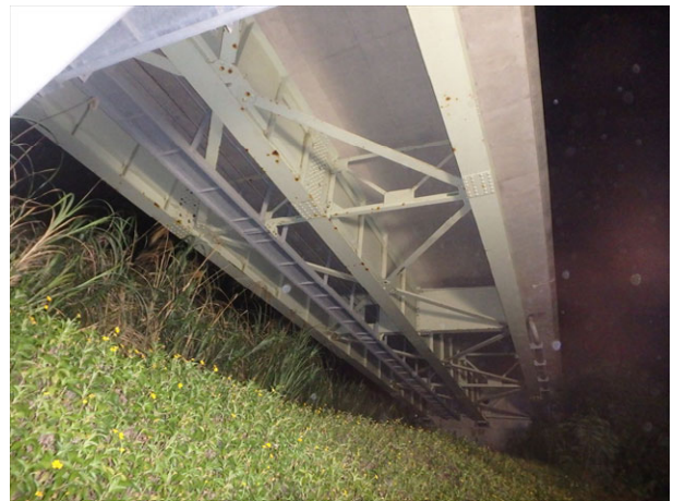
b) 桁下の雑草繁茂
