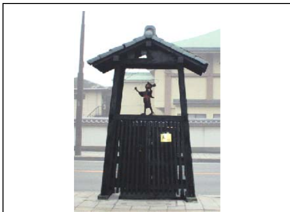
図 6-17 地上機器を覆うモニュメントを設置した事例（埼玉県行田市）
