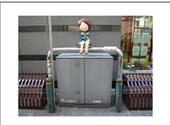
図 6-18 地上機器にオブジェを設置した事例（東京都調布市）
