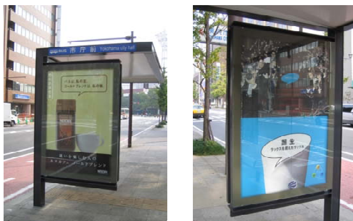
図 6-15 横浜市交通局のバス停上屋の設置状況
