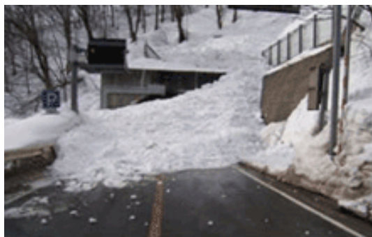
図 8-12 幹線道路でも雪崩が多発 (国道 113 号山形県小国町)
