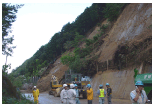
図 8-14 国道での大規模な土砂災害 (愛媛県新居浜市付近)
