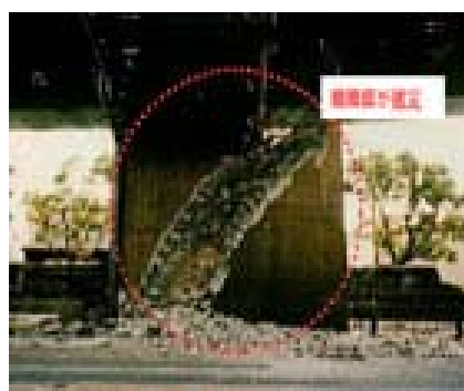
阪神高速道路の橋脚の被災 (神戸市長田区西尻池町)
