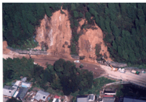
図 8-15 台風 21 号による高速道路の 大規模な土砂災害 (愛媛県新居浜市付近)
