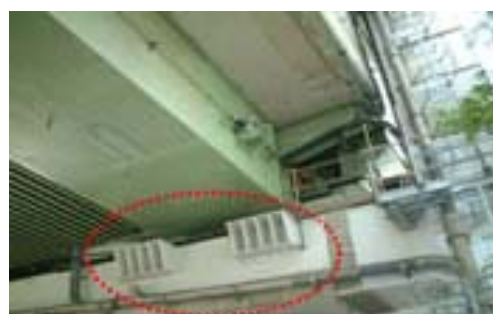
縁端拡幅ブラケットによる桁の落下防止
