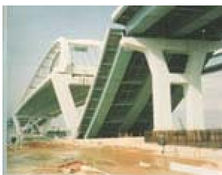
阪神高速道路の落橋状況 (西宮市甲子園浜)
