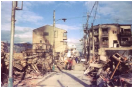
図 8-27 兵庫県南部地震の被災直後 (兵庫県松本地区)
