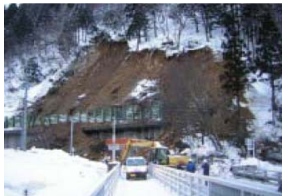
図 8-2 国道 156 号法面崩落箇所
