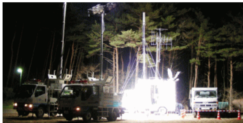
車載型無線基地局(岩手県陸前高田市)
