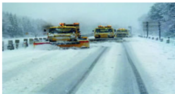
図 8-31 除雪車による除雪作業
