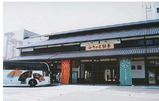
【道の駅「輪島」(石川県)】 大きな被害を受けた「旧門前町」の支援部隊の宿泊地として活用。(H19 能登半島地震)
