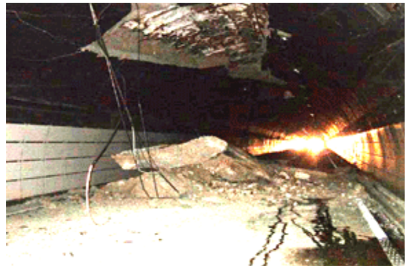
図 8-6 平成 16 年新潟県中越地震におけるトンネルの被災状況 (和南津トンネル)
