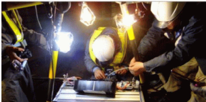
基幹ルートの通信ケーブル復旧作業
