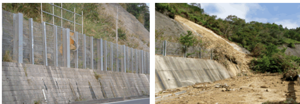
図 8-4 平成 16 年 台風 21 号豪雨による道路の被災状況
