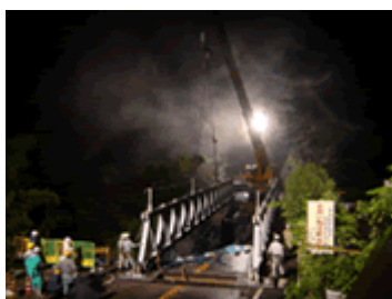
8/4 応急組立橋の架設
