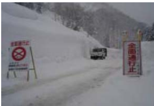
図 8-1 国道 405 号通行規制状況
