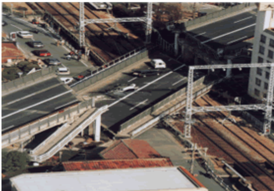
図 8-5 平成 7 年兵庫県南部地震における道路の被災状況
