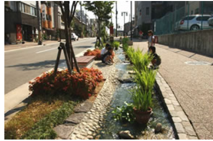
図 8-28 復旧後の広い道路 (兵庫県松本地区)
