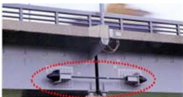
隣接する桁をケーブルで連結する構造
