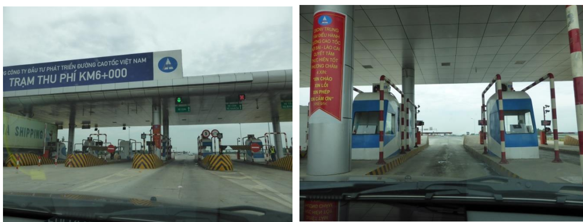
図 1-8-50 ノイバイ～ラオカイ高速道路の料金所
