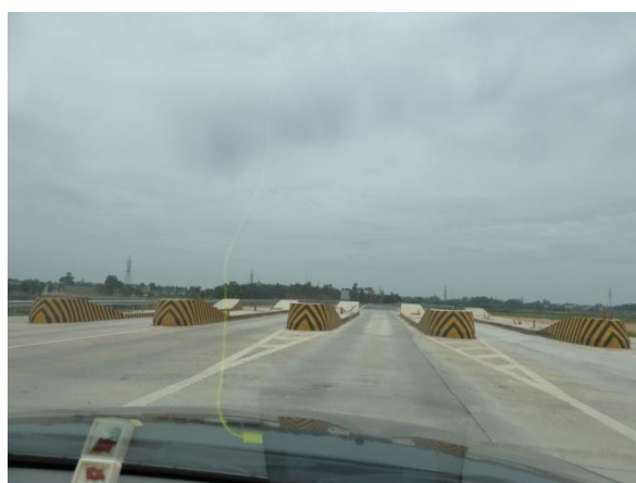
図 1-8-52 IC料金所（建設中）
