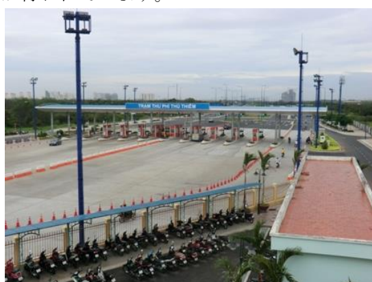
図 1-8-66 トゥーティエムトンネルの料金所
