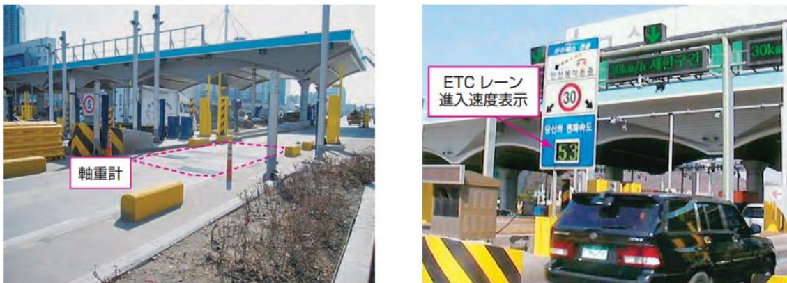
図 1-8-20 大型車レーン（左）と ETC レーン進入速度表示（右）
