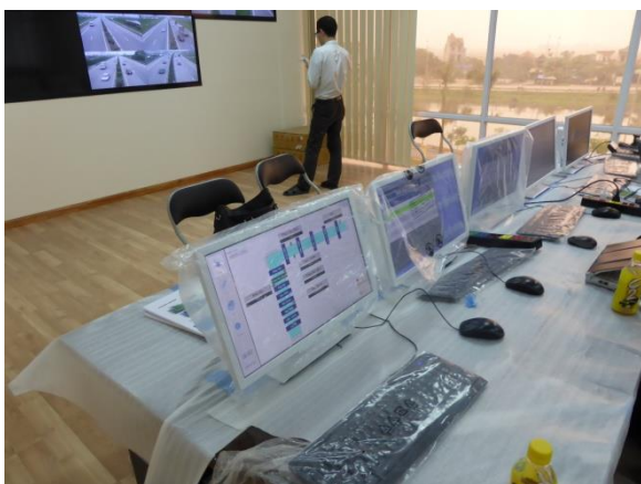
図 1-8-57 交通管制室 （ファッヴァン～ギー及びRR3区間）
