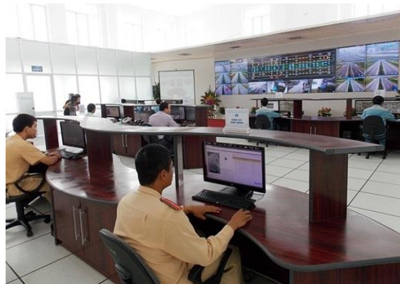
図 1-8-56 交通管制室（ギー～ニンビン区間）
