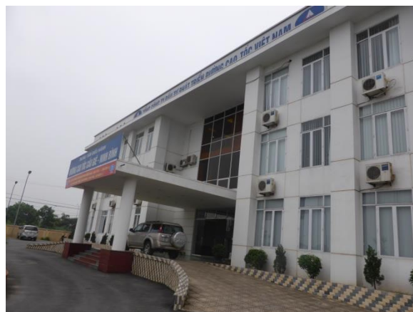
図 1-8-58 交通管制室が整備されている建屋
