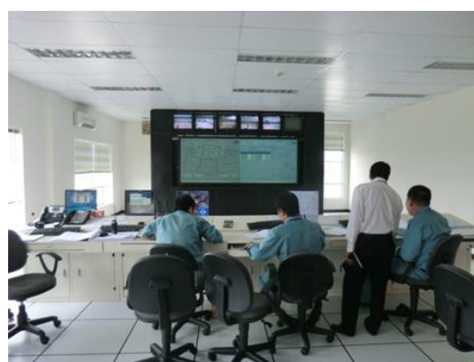
図 1-8-67 トゥーティエムトンネルの管制室
