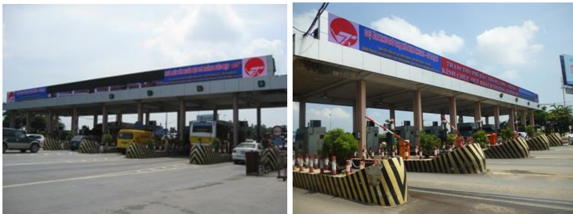
図 1-8-63 ノイバイ空港とハノイ中心地を結ぶタンロン～ノイバイ通りの料金所
