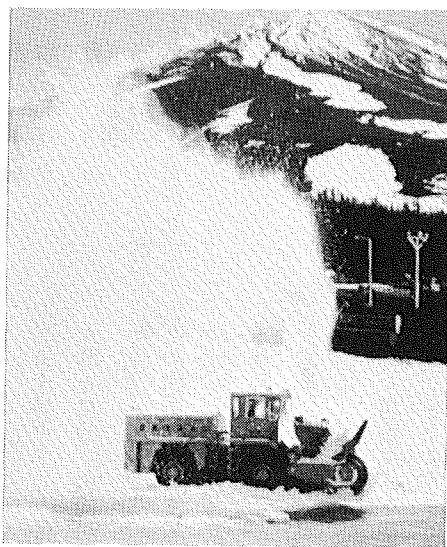
写真2 富士スバルライン除雪作業
