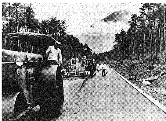
写真1 建設中の富士スバルライン(舗装工)
