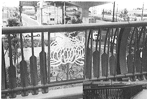
写真4 横断歩道橋高欄
