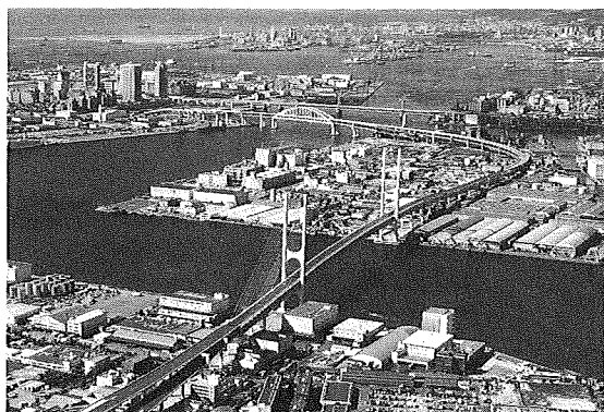
深江浜上空より六甲アイランド方面に阪神高速湾岸線を望む（5号湾岸線）
