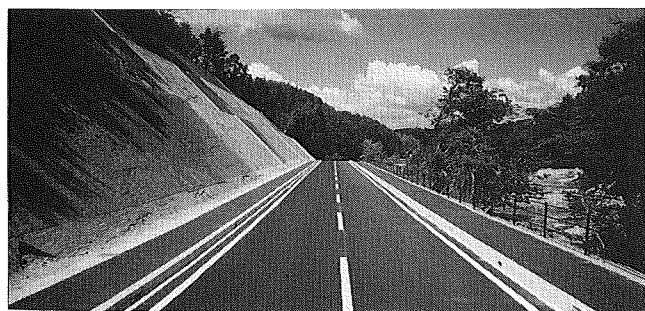
写真1 改良された主要地方道多治見白川線
