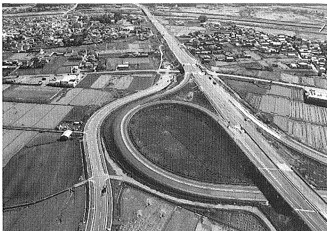
高規格幹線道路 下田 IC から国道45号百石道路を望む (平成7年3月供用予定)
