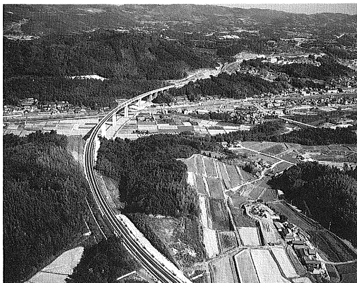
写真5 大分空港道路八坂大橋付近（杵築市）
