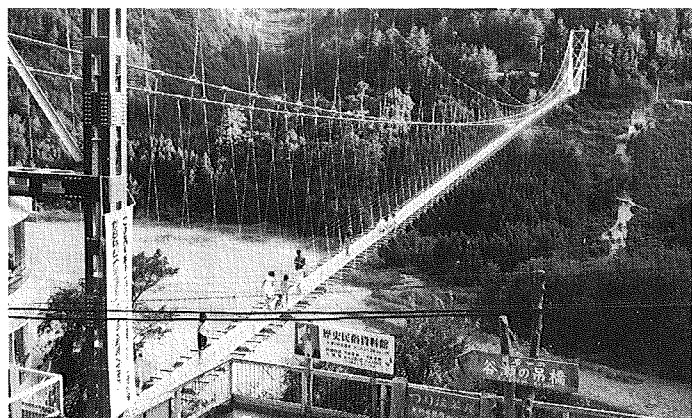
写真3 日本一の谷瀬の吊橋
