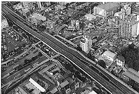
国道43号岩屋高架橋
