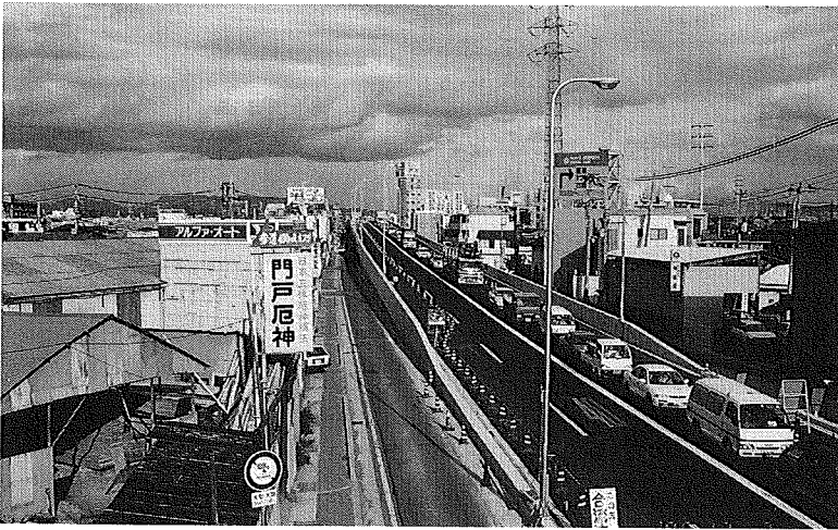
国道171号門戸高架橋 (H7.11.28開通)
