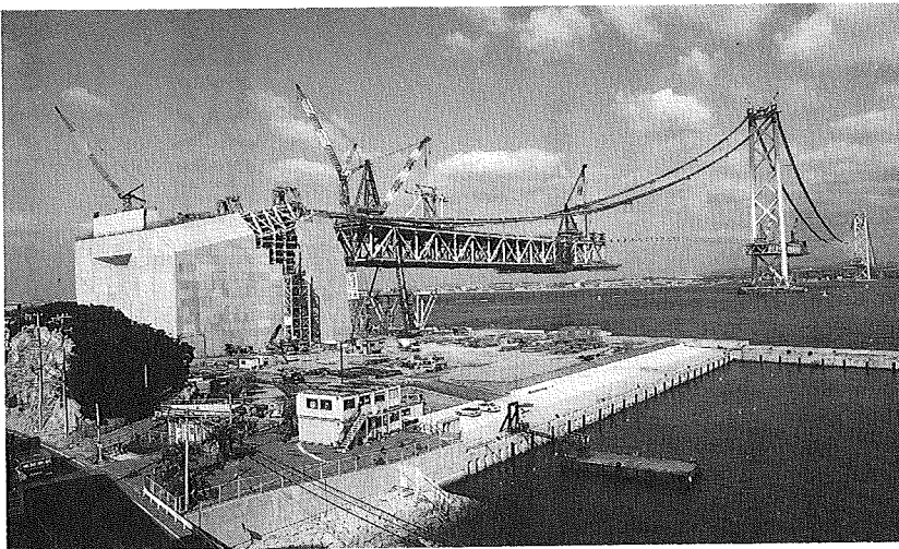
明石海峡大橋架設現況
