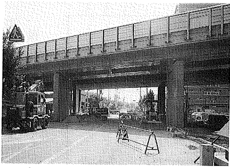
写真7 本復旧完了(H7.7) 名神瓦木西高架橋
