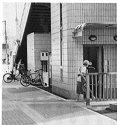
磯子駅西口エレベーター 2 号機 1 階
