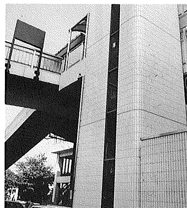
磯子駅西口エレベーター 1 号機
