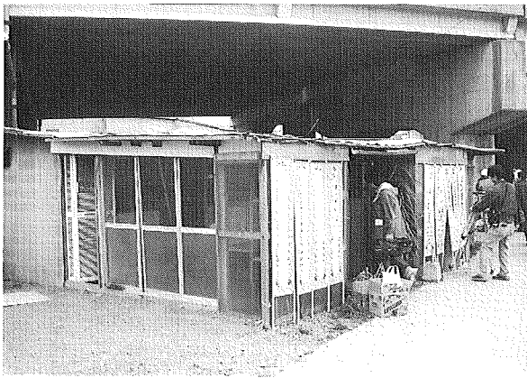
撤去前の店舗
