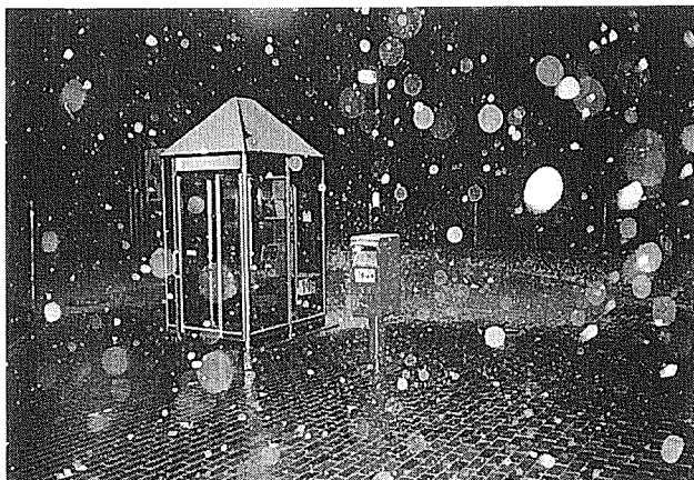
写真8 〔太陽エネルギーによる消融雪施設〕 現地融雪状況（道の駅「かみおか」）
