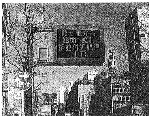
写真2 [路面情報自動表示システム] 情報提供中の道路情報板
