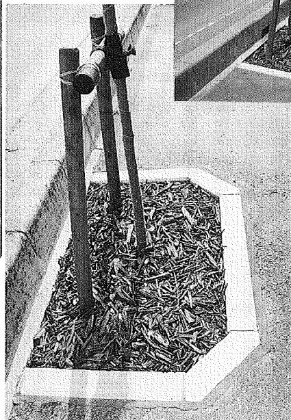
▶チップ材敷均し状況
