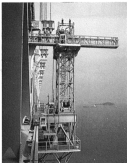
橋のあらゆる部分に自由に接近できる 補剛トラス外面作業車
