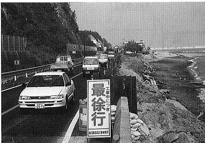
応急復旧完了（２車線交通開放）
