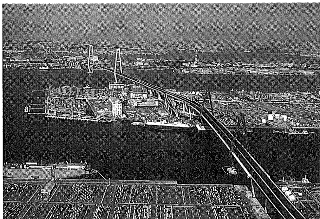
本年3月に開通した伊勢湾岸自動車道(名港トリトン)
