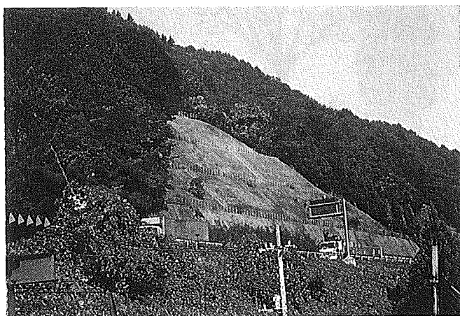
コンクリート吹付けされた長大のり面
