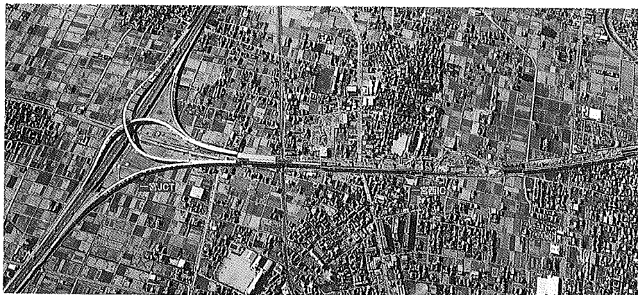
工事が進む東海北陸自動車道・一宮JCT
