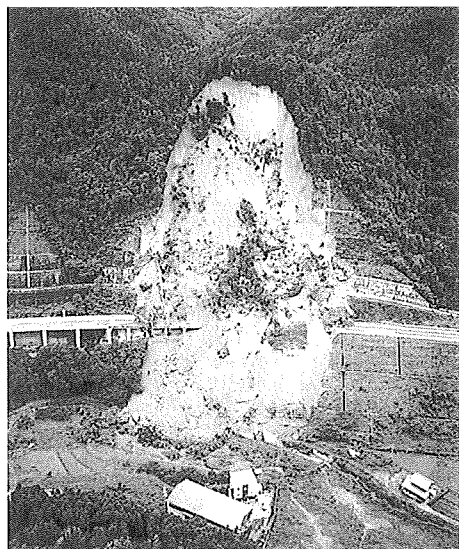
東海北陸自動車道・美濃市口野々 山側の斜面が崩壊、北陸自動車道の本線を埋める
