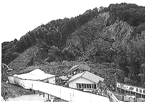
写真 3-1 被災状況全景
