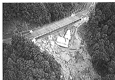
写真 2-2 応急組立橋設置状況
