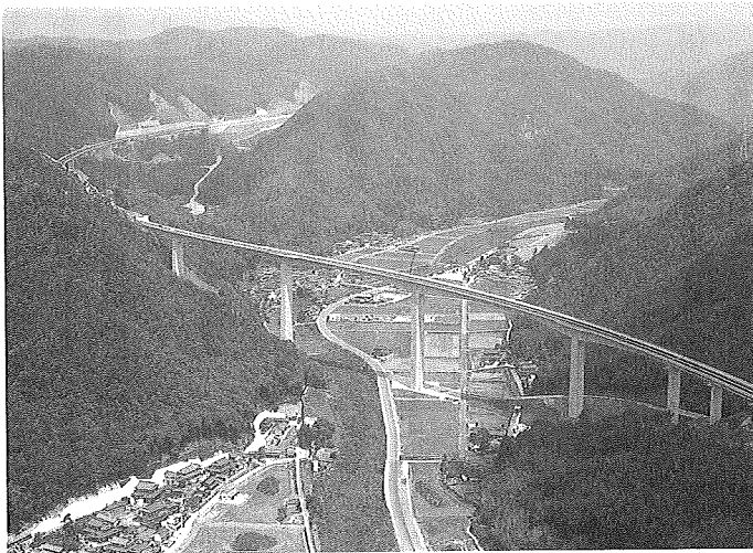
中国横断自動車道岡山米子線 見延橋（総社市）
