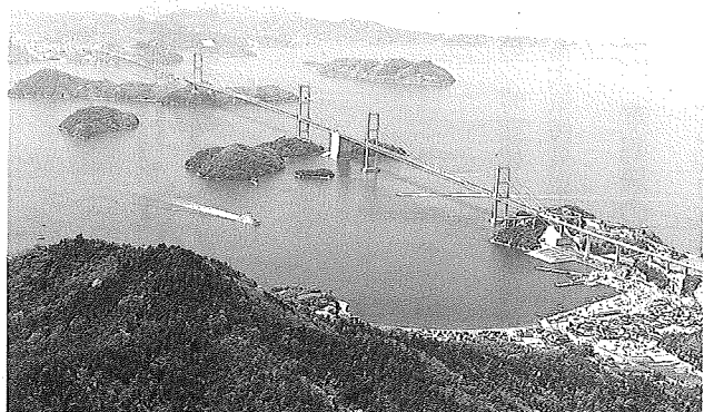
三連吊橋 来島海峡大橋（平成11年完成）
