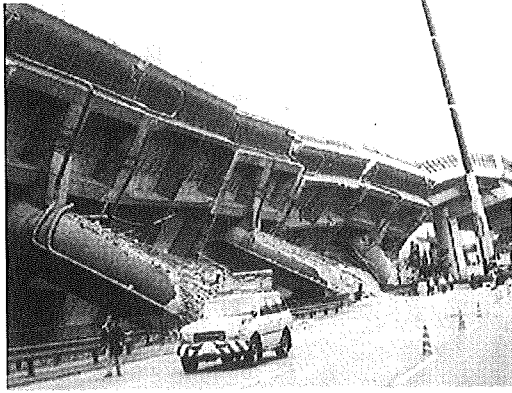
写真1 兵庫県南部地震(1995年)による阪神高速道路RC橋脚の倒壊
