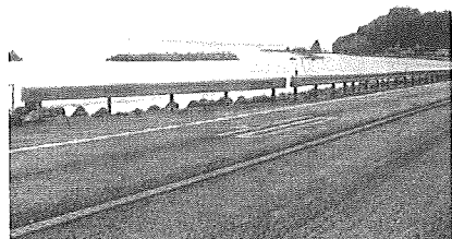
■防護柵更新前の状況
