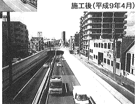
写真2 環状8号線井荻交差点の立体化
