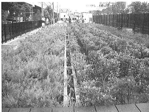
写真3 土壌脱硝装置の設置例
