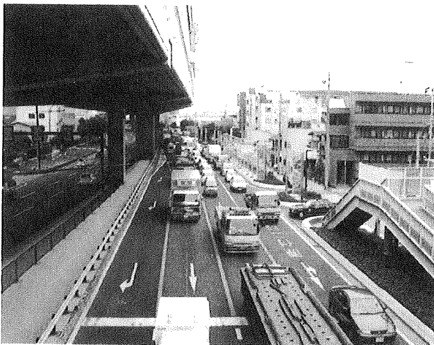
国道43号及び阪神高速3号神戸線
