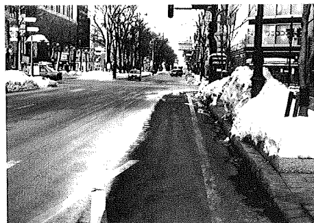
写真5 路肩ロードヒーティング (一般国道36号)
