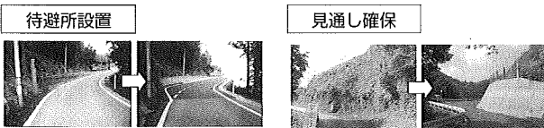
図3 1.5車線の道路整備
