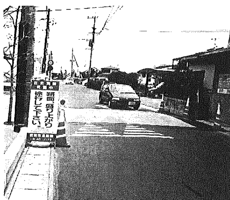
写真1 はんぷの設置状況（佐賀市）
