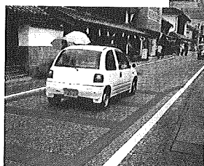
写真6 イメージハンプによる速度抑制の様子 (本町通り)
