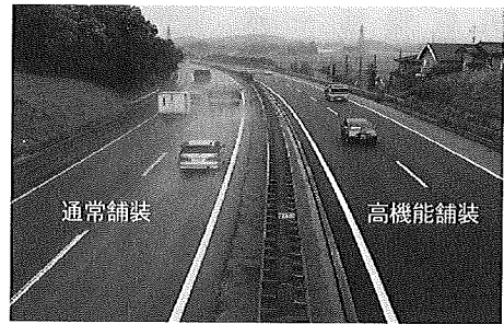
写真1 雨天時対策（高機能舗装）
