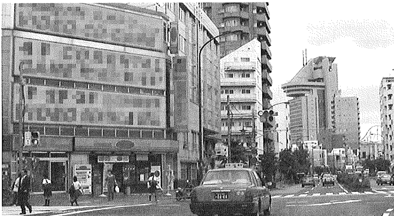
写真6 一般国道254号 東京都文京区小石川2丁目付近
