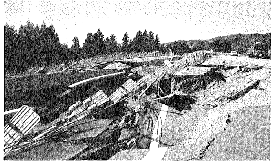
写真1 関越道（越後川口～堀之内）被災状況
