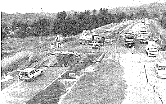
写真2 関越道（越後川口～堀之内）応急工事状況
