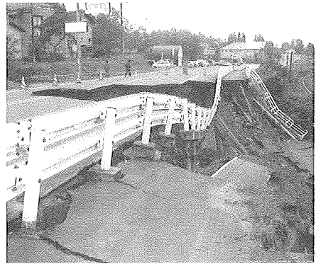
写真4 国道17号川口町天納地先の道路崩壊現場
