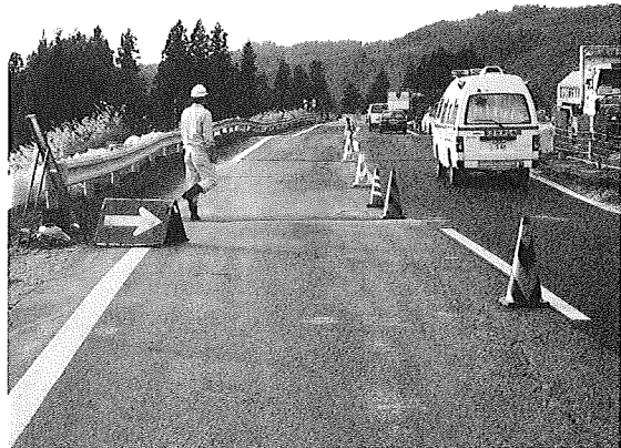
写真3 関越道（越後川口～堀之内）緊急車輛通行確保状況
