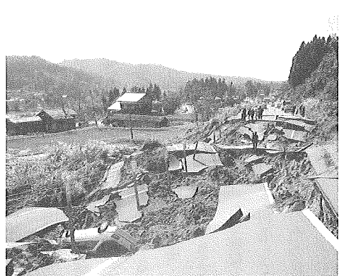
写真6 国道17号川口町地内の道路崩壊現場
