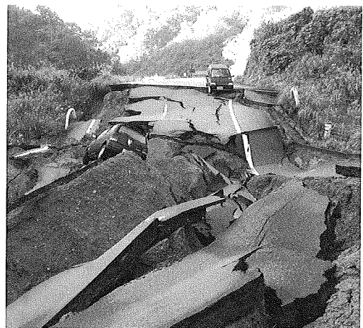
写真2 一般国道252号 (新潟県魚沼市(旧堀之内町))
