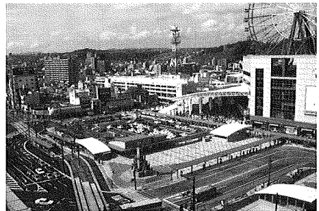
道路上の電停を駅構内へ移設 (鹿児島中央駅・シェルター、電停)
