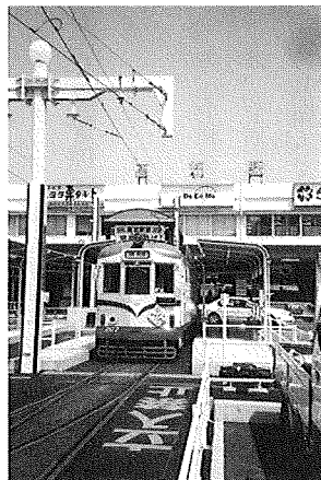
駅手前の電停を駅前広場へ乗り入れ (高知駅・走行路面、路盤、電停)
