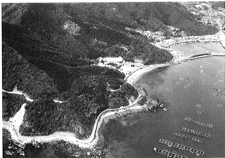
写真3 県南の海岸部の県道
