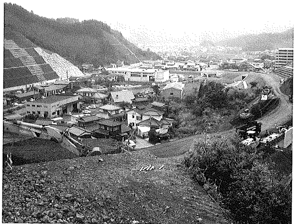
写真5 建設中の東九州自動車道佐伯I.C. (仮称) 付近
