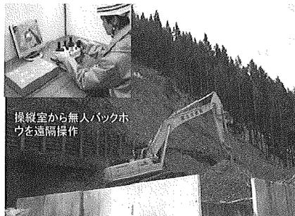
斜面からの土砂崩落が続く現地で、地すべり土塊を除去するため、遠隔操作により二次災害を避けながら災害復旧を実施。
