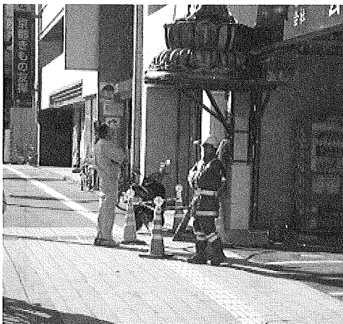
写真3 発見当初の通行規制状況
