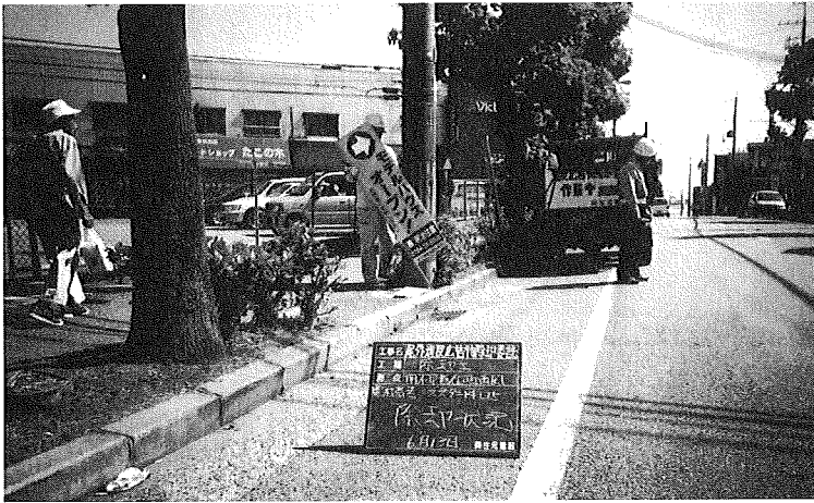
写真4 委託業者による撤去作業
