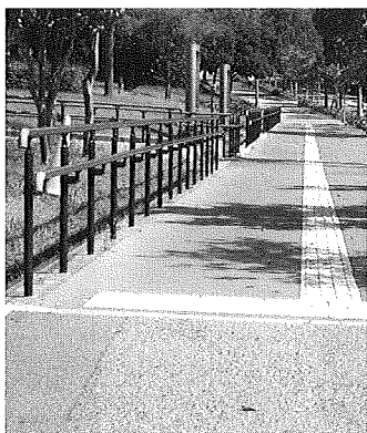
写真2 手すりの設置状況
