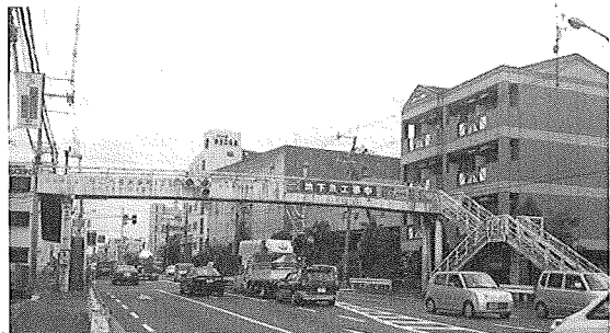
写真1 歩道橋全景（撤去前）
