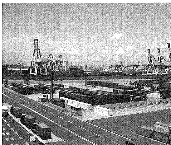
写真9 日本郵船コンテナヤード
