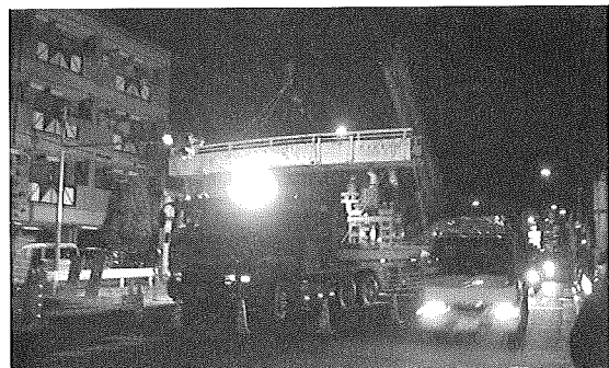
写真2 歩道橋撤去状況
