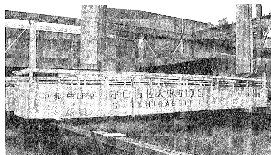
写真3 歩道橋仮置状況
