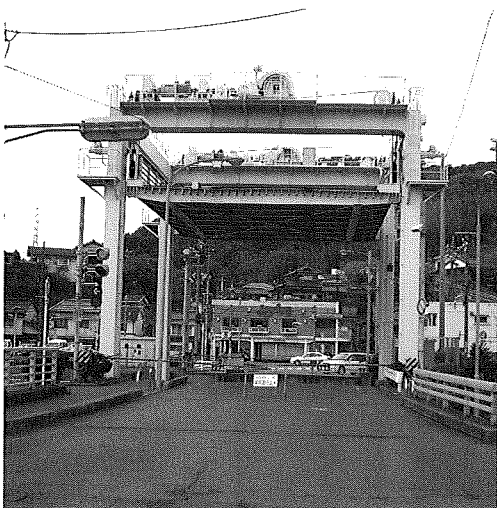
写真5 船舶を航行させるため、路面が上昇
