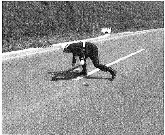
写真1 道路上での落下物回収作業
