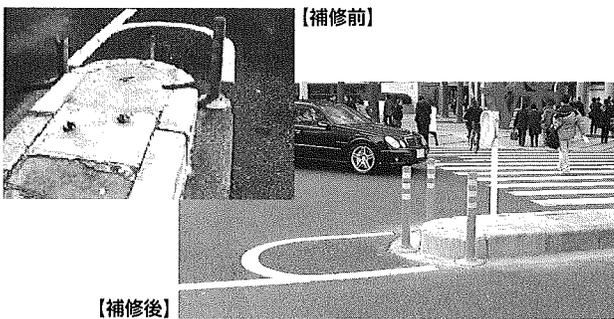
写真3 自動車が衝突して折れたボールを補修
