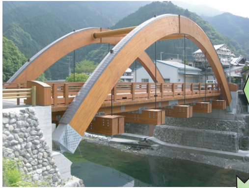
写真9 町道に架かる木製アーチ橋「栲原橋」
