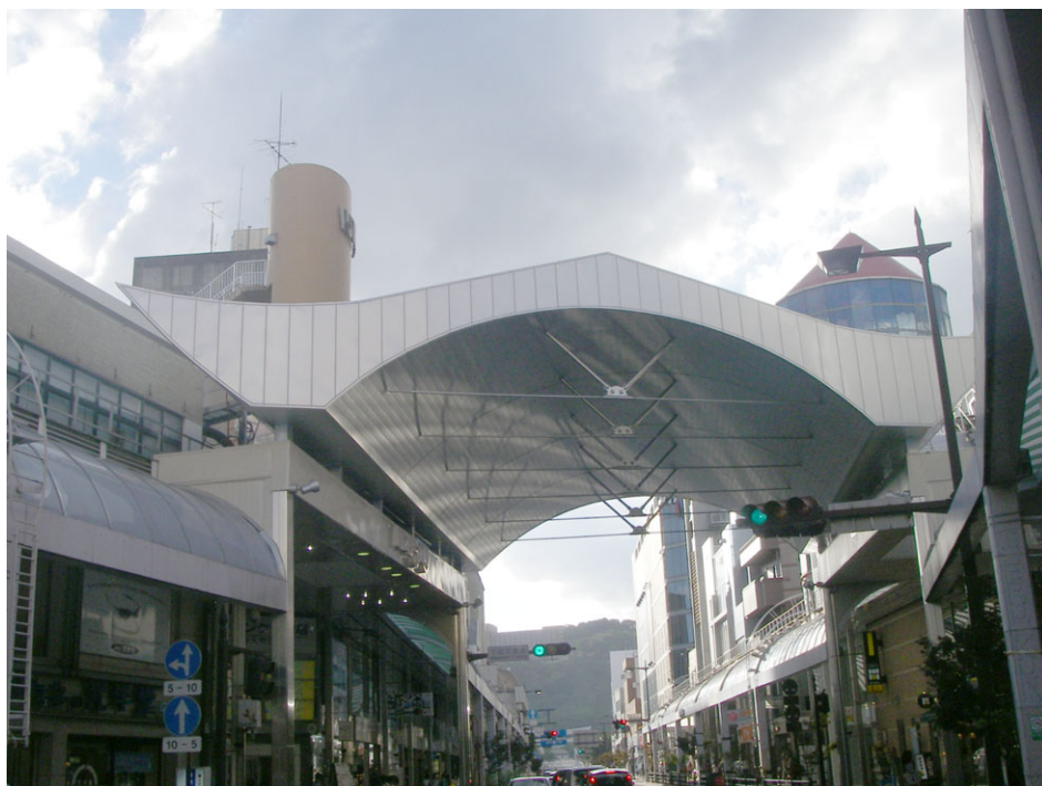
（写真② 完成したアーケード）
