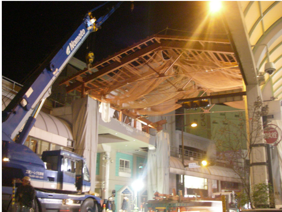
参考：（アーケード設置工事状況の様子）
