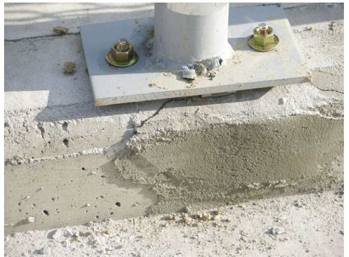
< 3月8日午後（フェンス再設置後） >
