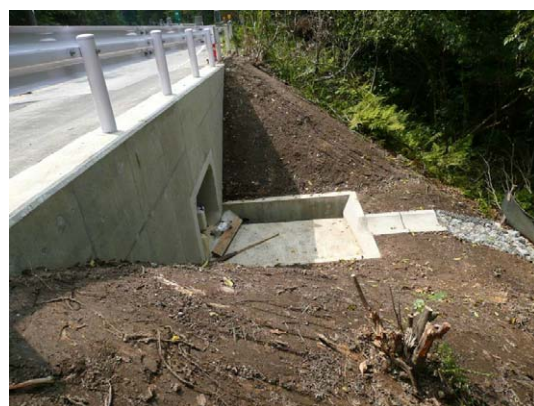
写真 8 出入口付近（竣工直後、水溜まる前）
