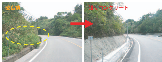
写真2 張りコンクリート
