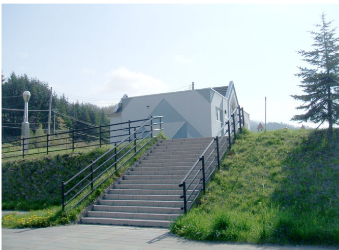
写真1 楓トイレ外観①
