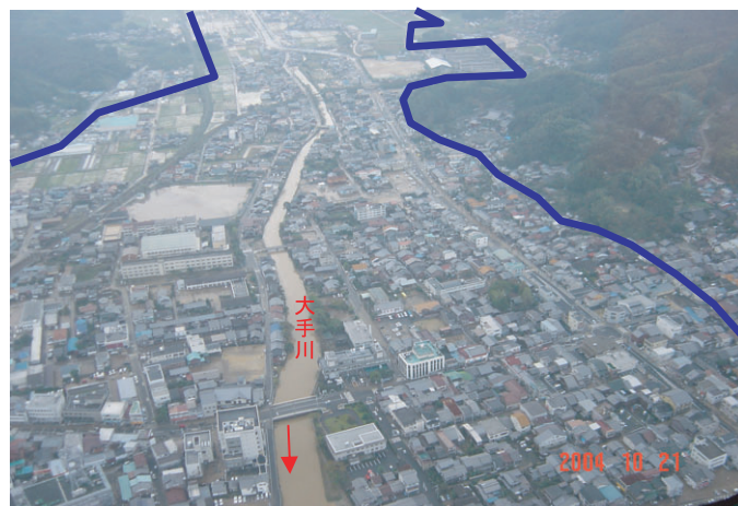
台風23号の被害状況
