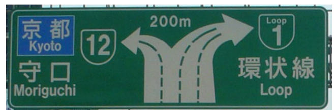
写真－3 1号環状線・12号守口線分岐部の案内標識改善
