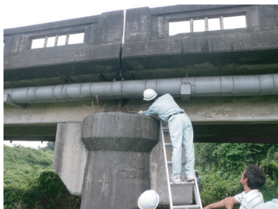
写真1：職員による点検状況
