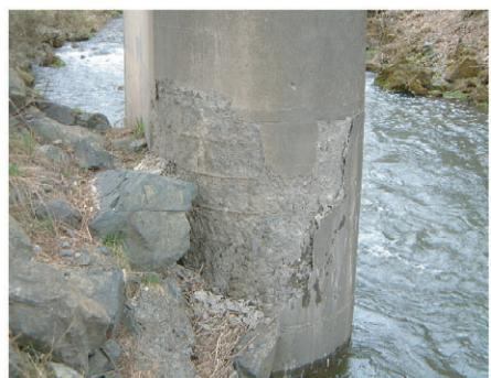
橋脚（橋を支える支柱）が、川の流れで表面のコンクリートが削られ鉄筋が見えています。
