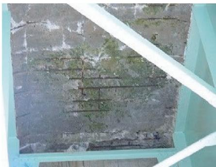
床版（車や人が乗るところ）を下から見た写真ですが、コンクリートが剥がれて鉄筋が露出しています。
