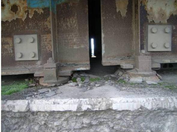
写真-8 支承の台座コンクリートの破損
