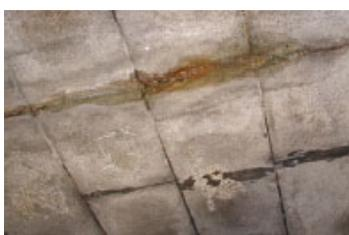
写真-8 漏水状況
