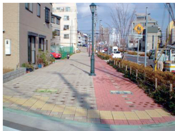
自転車走行空間の整備事例（須磨区中央幹線）
