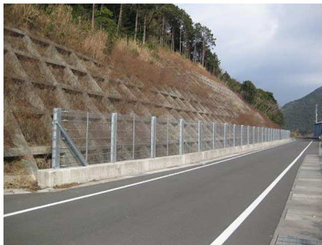
写真④ 落石対策により安心・安全が確保された道
