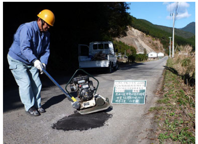
写真⑫ シルバー人材センターによる路面補修
