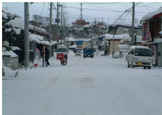
写真2 消流雪溝 整備後
