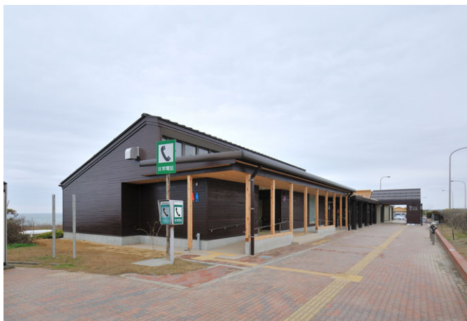
バリアフリー化したトイレの外観
