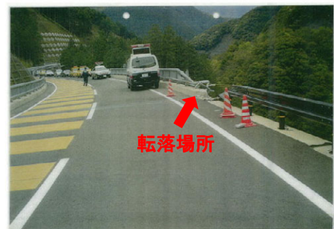
事故現場状況写真
