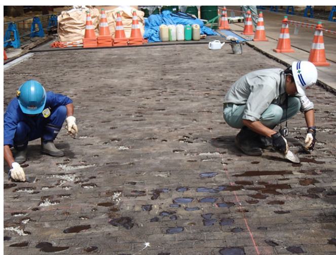
【木塊舗装の保全措置の様子】
