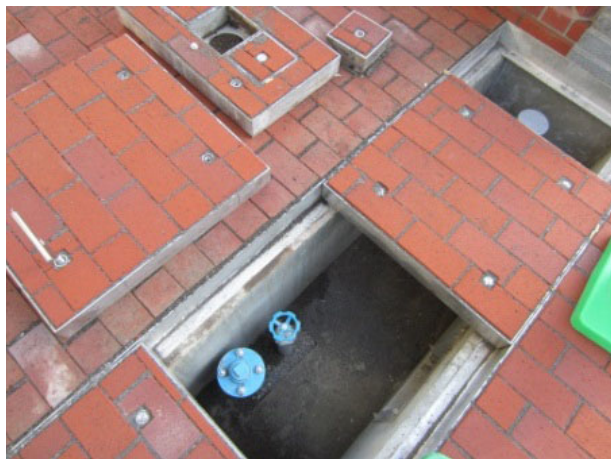
【植栽柵間のトレンチ】
